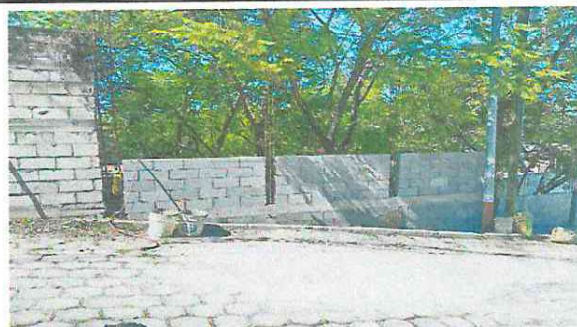
Foto 2: seguimiento de avances del muro perimetral
