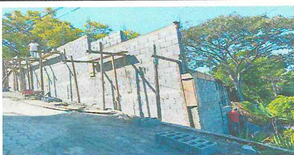
Foto 5: avances del muro perimetral esquina del establecimiento
