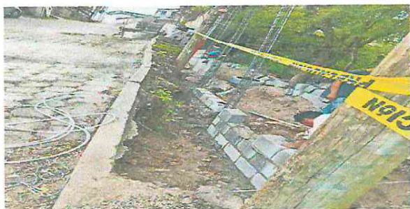
Foto 1: avases de los trabajos del muro perimetral
