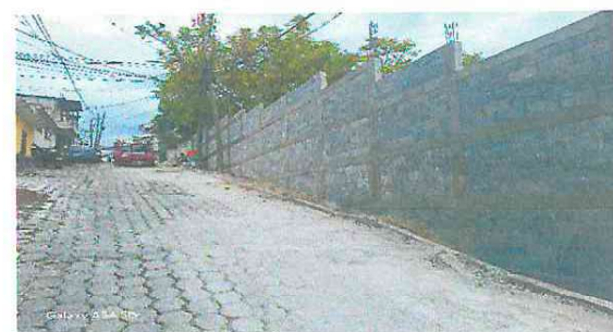
Foto 6: termino de los trabajos realizados en muro perimetral
