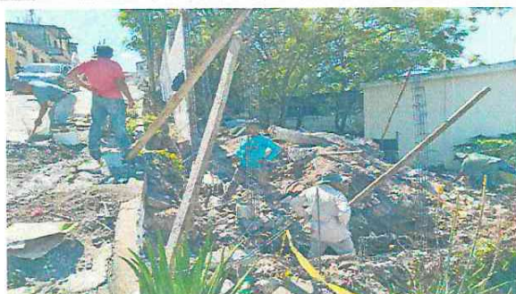
Foto 3: trabajos de levantado de muro perimetral
