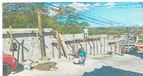
Foto 4: trabajo y seguimiento del muro perimetral
